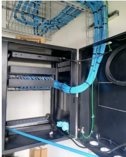
Figura 3. Servicio de cableado estructurado de redes con cable UTP.
