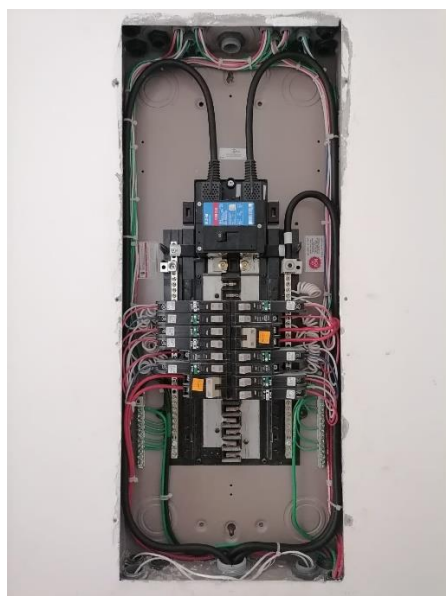
Figura 7. Servicio de instalación de sistemas eléctricos baja tensión.
