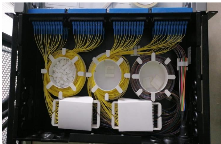
Figura 5. Servicio de Fusión de Fibra óptica Monomodo.
