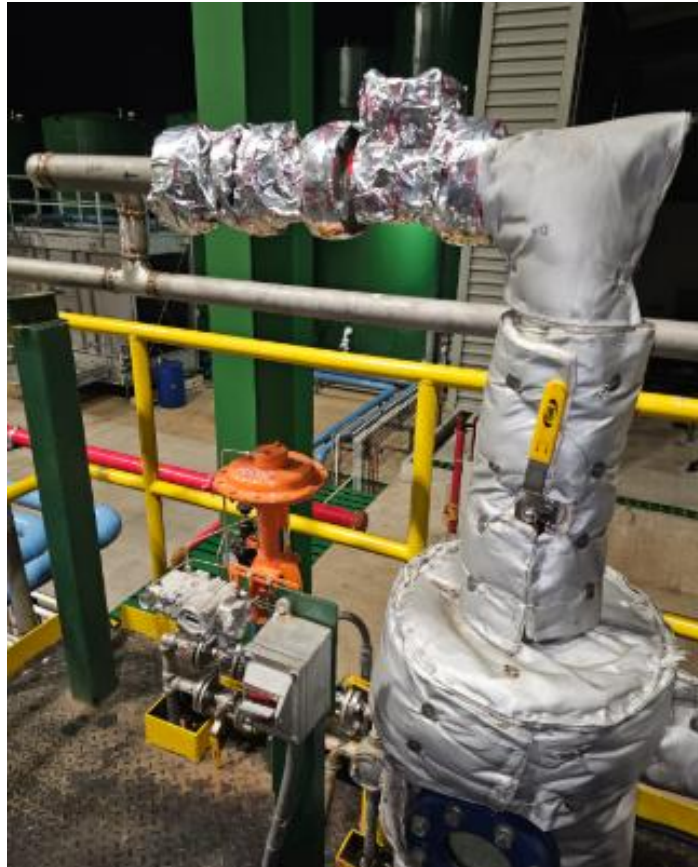
Figura 11 Aislamiento térmico en la sección del sistema
