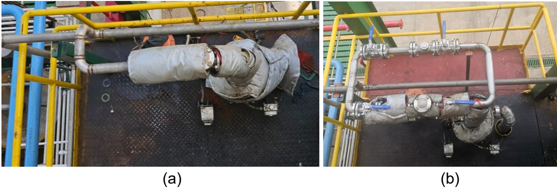
Figura 18 Antes y después del ensablado del bypass
