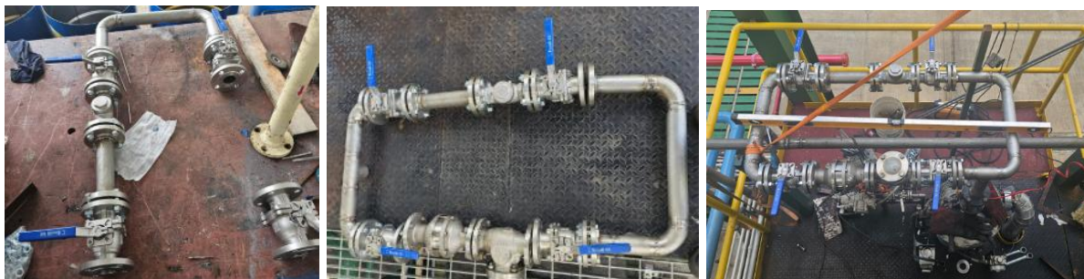
Figura 17 Secuencia de armado del bypass
