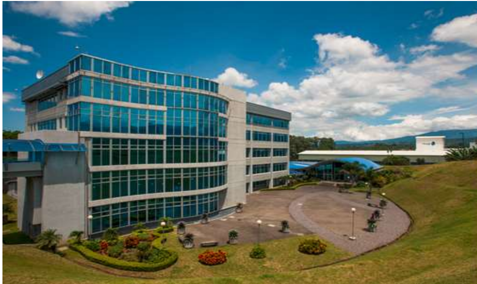
Imagen 4 Edificio Corporativo de Florida Bebidas
