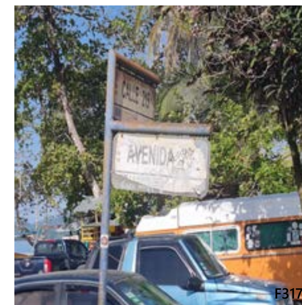
Señalización en mal estado
