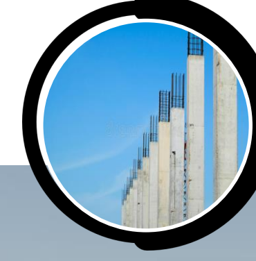
COLUMNAS DE CONCRETO
