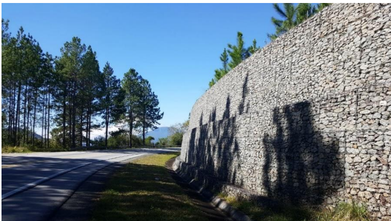
Figura 3 Muros de gaviones
