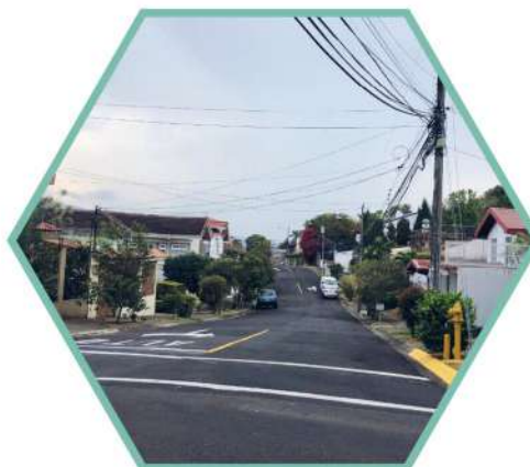
6. Calle A.020 (terciaria)
