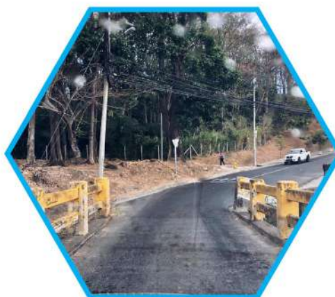
2. Puente sobre río
