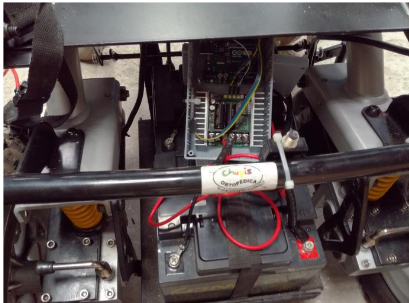
Figura 40 Colocación de la caja de control en posición final
