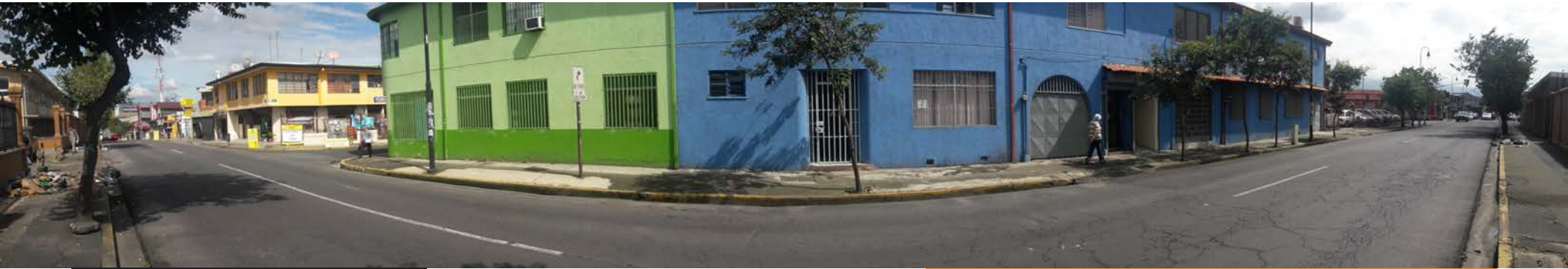
F. 050_fachada Norte_Autoría Propia
