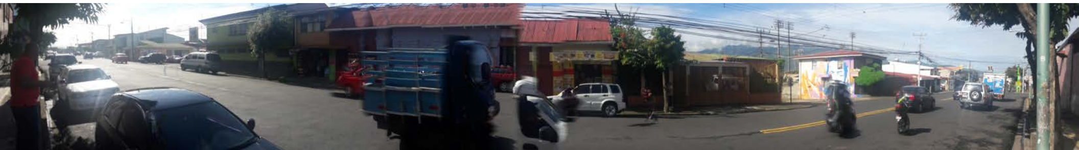
F. 051_fachada Sur_Autoría Propia
