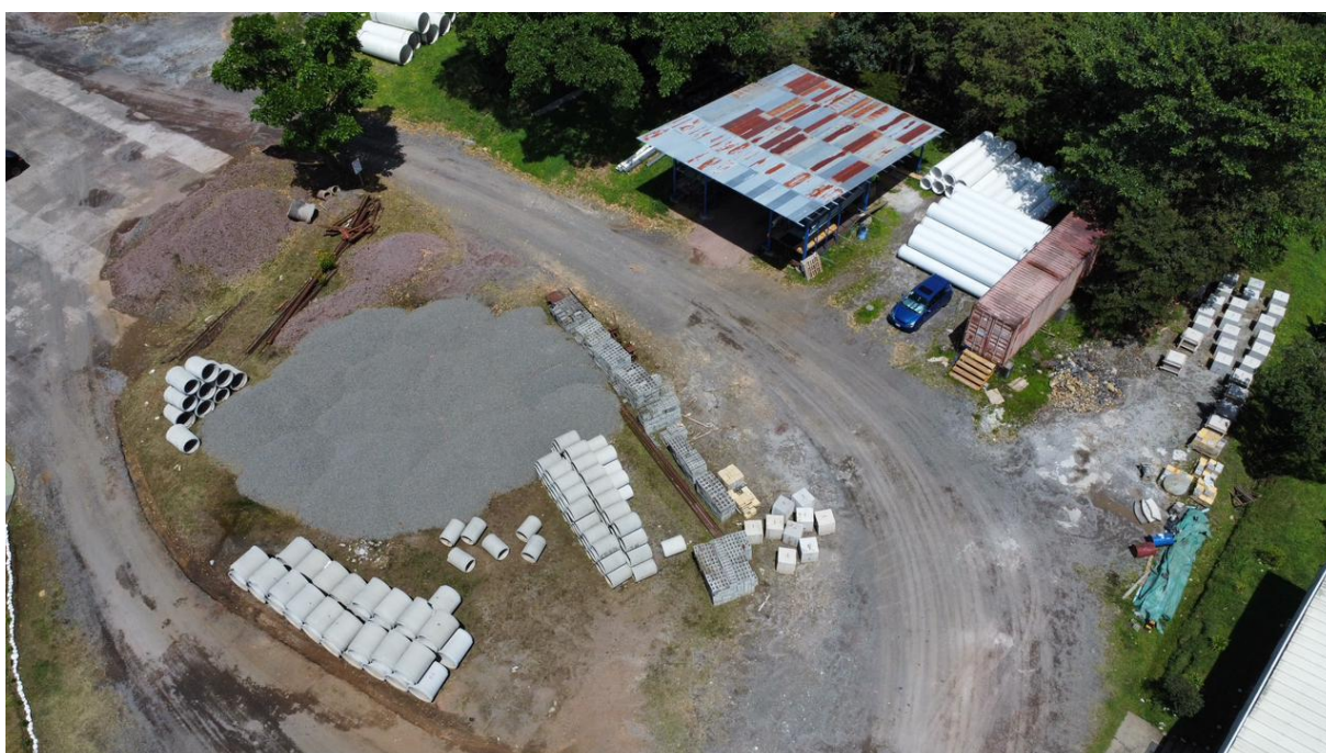
Anexo #29: Bodega de materiales Vista aérea.
