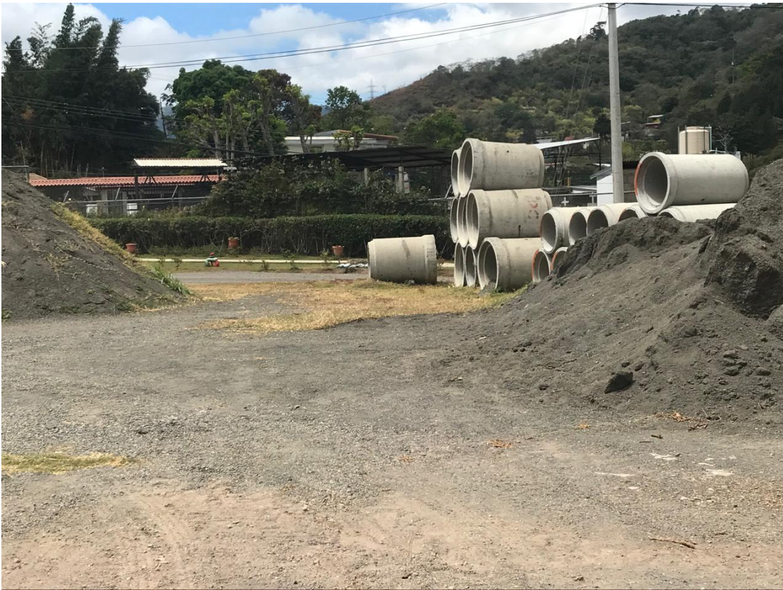
Anexo #23: Zona de agregados.
