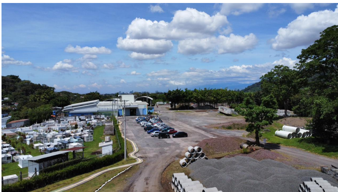
Anexo #27: Zona de parqueo y agregados.
