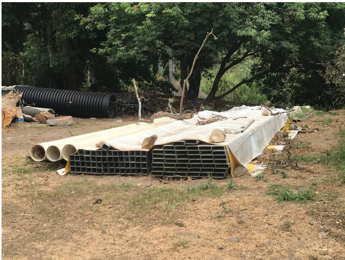
Anexo #28: Zona de materiales.
