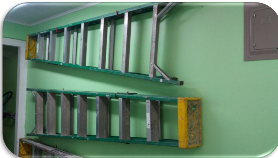
Ilustración 7: Colocación de escaleras
