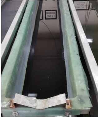
Ilustración 11: Tanque 3 (Desoxidación) – Coopesa
