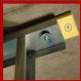
FIBRA COMPRIMIDA PARA DESLIGAR LAS PAREDES LIVIANAS
