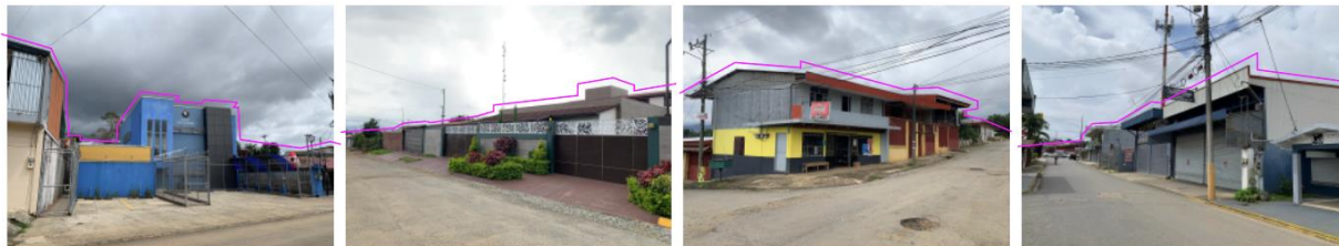
Figura 73 Perfiles de edificaciones presentes en el sitio. Fuente: fotografías propias.
