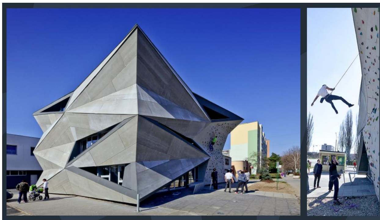
Figura 16 Instalaciones Centro Cultural y Deportivo Važecká. Fotografías por: Atrium Architekti.
