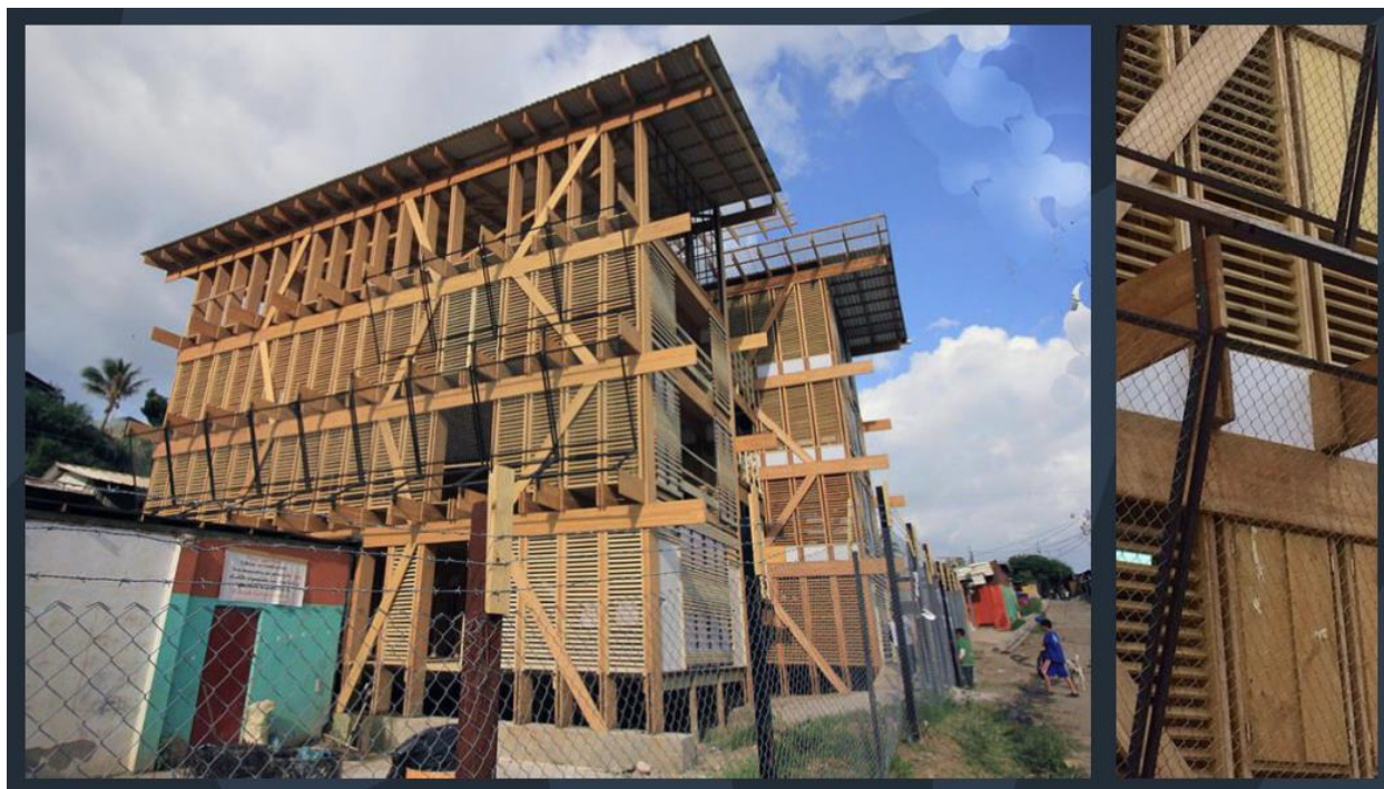
Figura 2 Edificio SIFAIS CUEVA de Luz. Fotografías: Ingrid Johanning.
