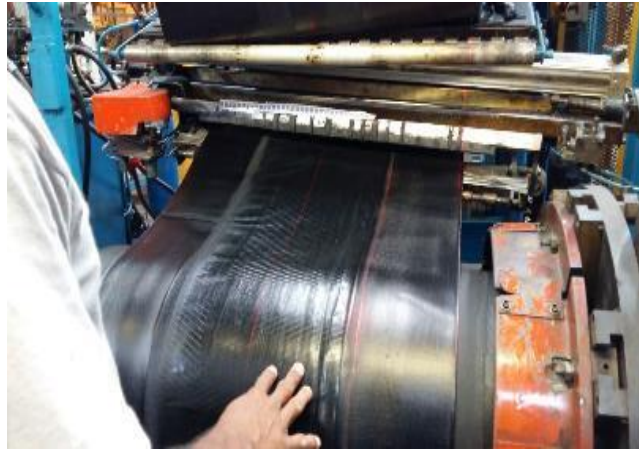
Figura 51: Colocación de sellante en máquinas individuales.
