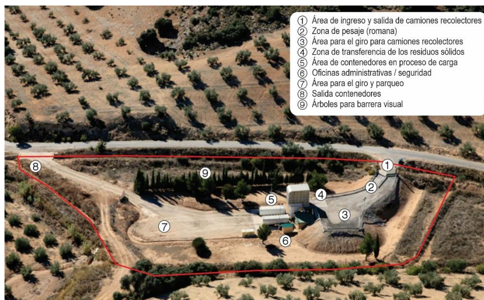
Figura 17 Imagen de un centro de transferencia de residuos ubicado en Granada, España.
