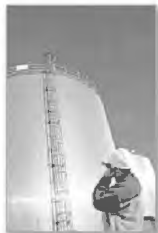
Varios productos químicos fluyendo en un tanque
