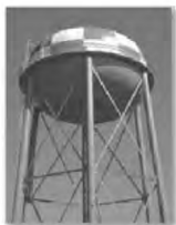
Torre de agua
