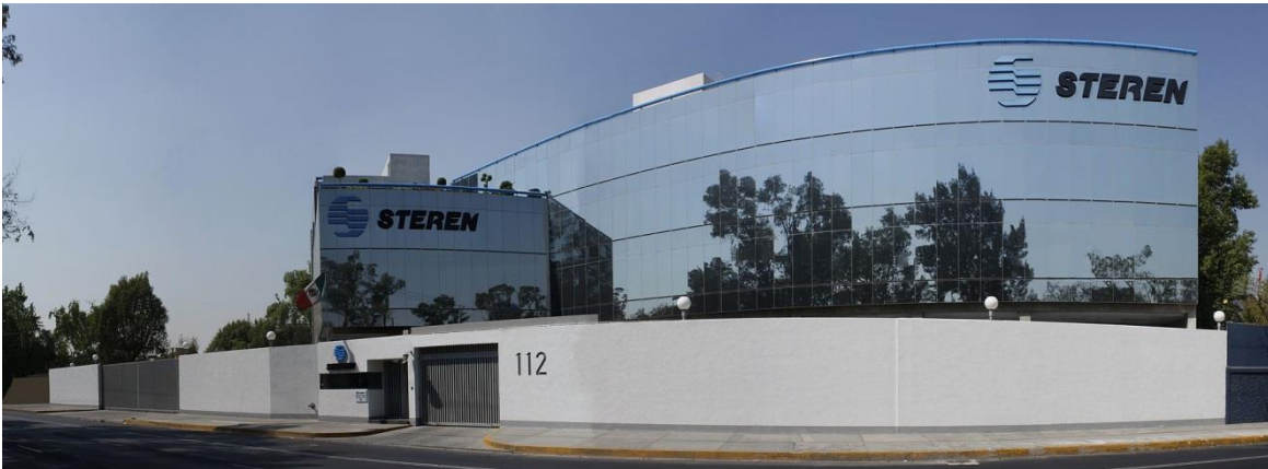
Ilustración 4. Edificio Corporativo, México
