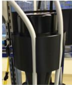
Figura 12: Tubos presionados en las ranuras
