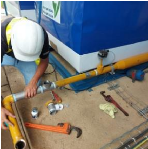
Ilustración 18 Instalación de equipos de medición
