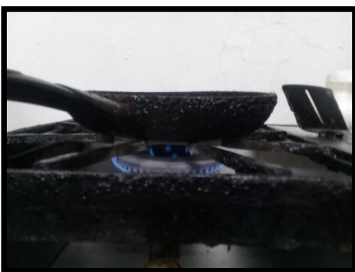
Figura N° 17. Estado del equipo del servicio de alimentos, Vigui 2017
