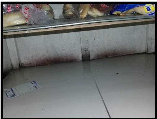
Figura N°10. Piso debajo de un mueble del servicio de alimentos, Vigi 2017
