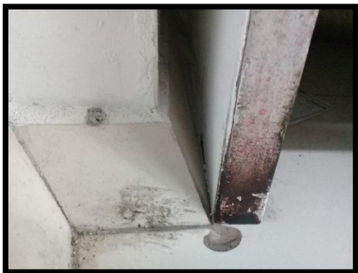
Figura N°9. Esquina de la estructura del servicio de alimentos, Vigui 2017
