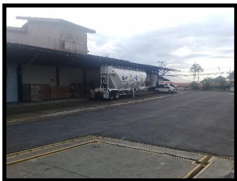
Figura N°3. Edificio planta fideos, Vigui 2017
