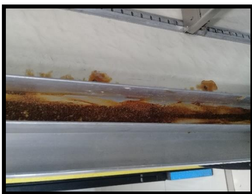
Figura N°8. Marco de la cámara de refrigeración, Vigui 2017
