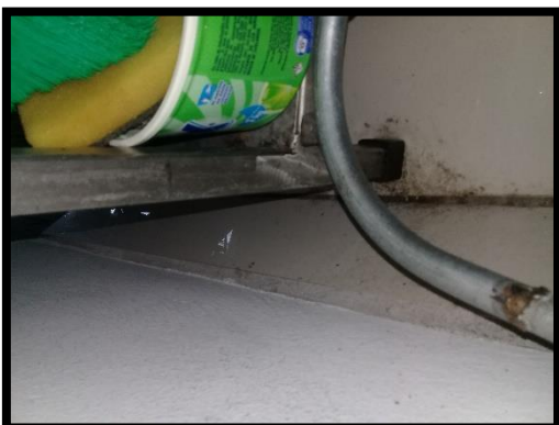
Figura N°11. Piso debajo de un mueble del servicio de alimentos, Vigi 2017
