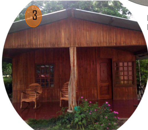
IMAGEN 88: Casa de habitación Fuente: Fotografía de la autora.(2015)
