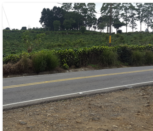
INEXISTENCIA DE ACERAS
