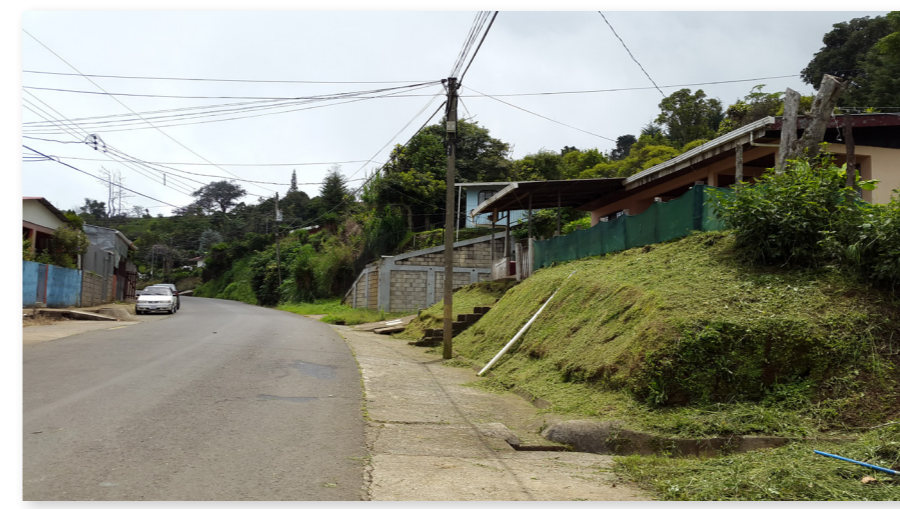
CALLE DE BAJO TRÁNSITO, EN BUEN ESTADO
