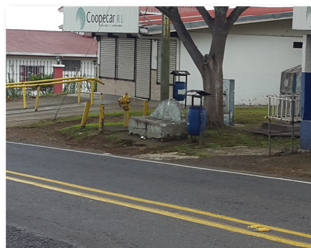
MOBILIARIO EN MAL ESTADO
