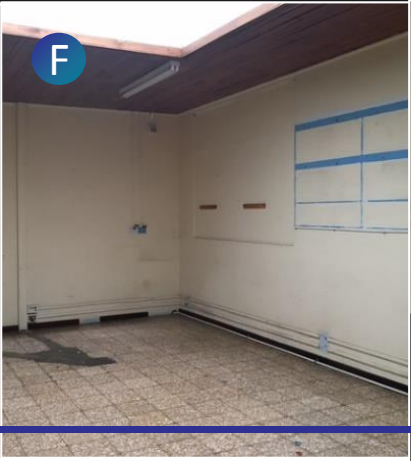
Imagen 79. Paredes livianas en mal estado
