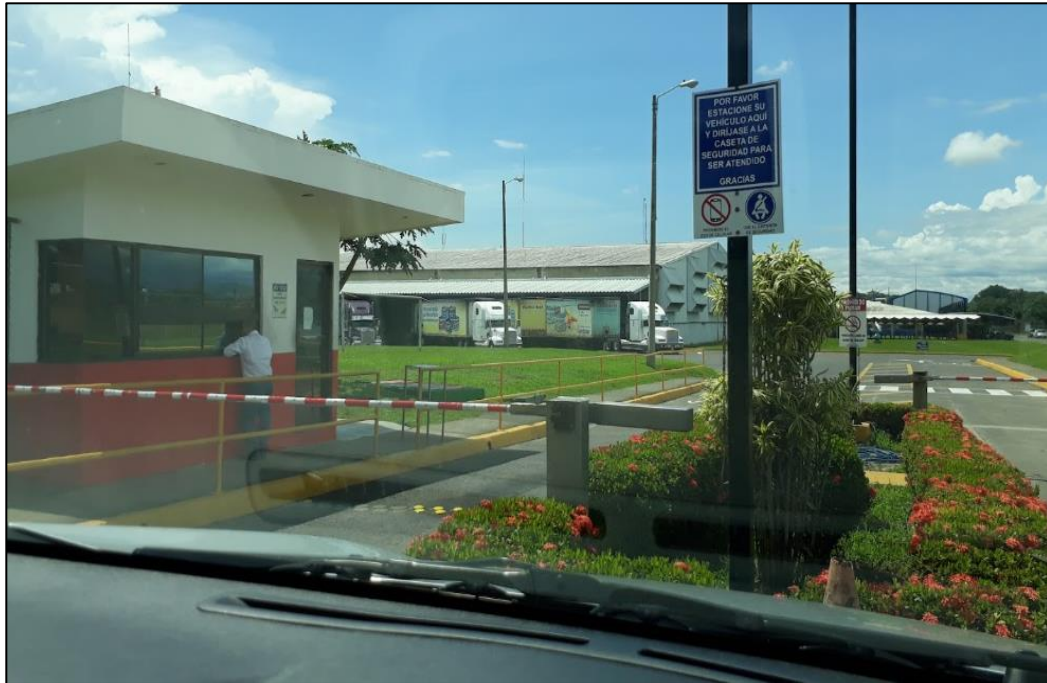
Imagen 5. Entrada a la Planta de Alimentos Prosalud S.A
