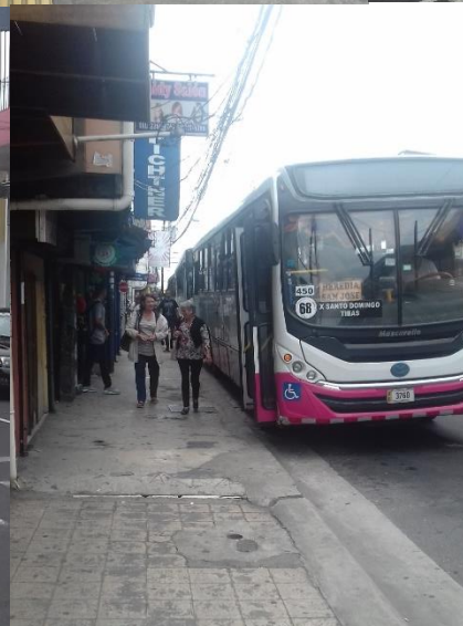
Estado de las aceras. 4
