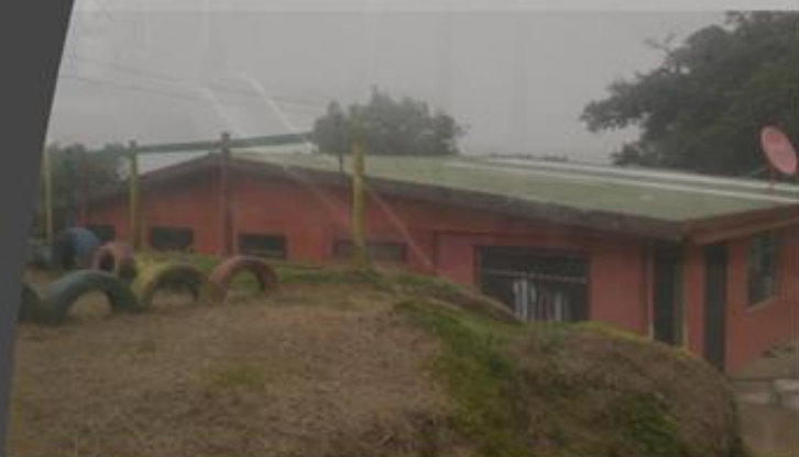
Fotografía 1.10. Albergue Excelencia Familiar. Fuente Propia.
