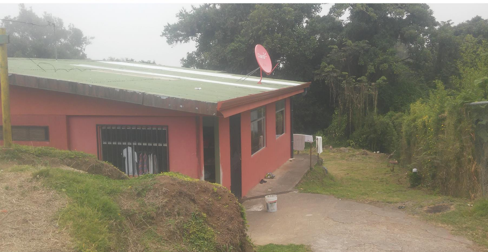
Fotografía 1.2. Albergue Excelencia Familiar. Fuente Propia.
