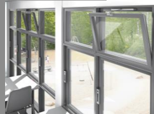
Imagen 5.5: Ventana tipo abatibles en la parte superior. Recuperado de: https://www.Dh-partner.Es/d-h-mechatronic-ag-dh-partneres.Html
