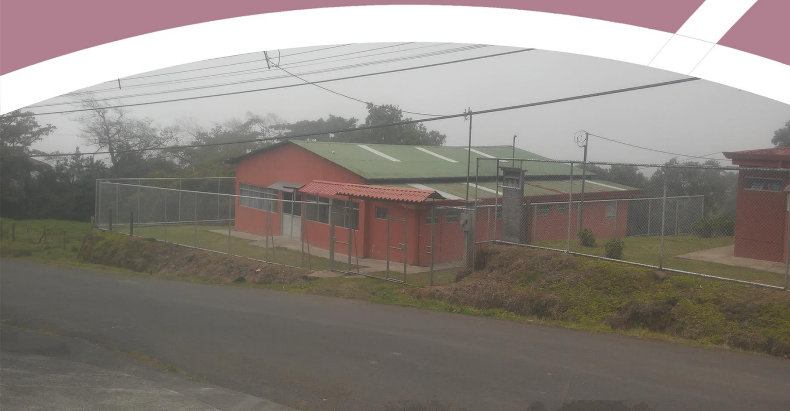
Fotografía 1.1. Albergue Excelencia Familiar. Fuente Propia.
