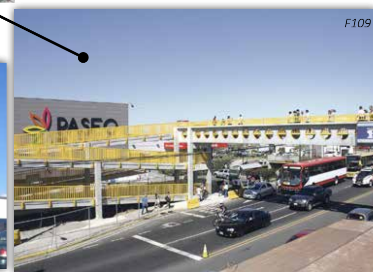
Ilustración 56. Puente Peatonal Paseo de Las Flores.
