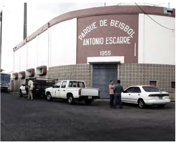
| 2.22 | Fachada | Autoría Propia
