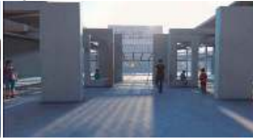
VISTA ELEMENTOS EN ACCESO
