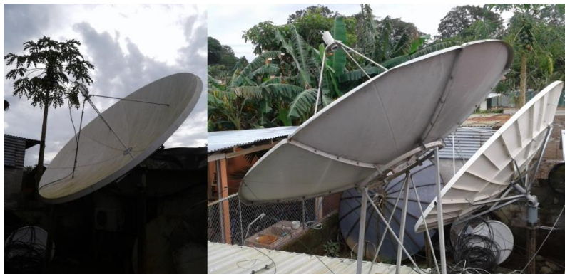
Figura 17: Antenas parabólicas propiedad de la empresa que capturan las señales satelitales
