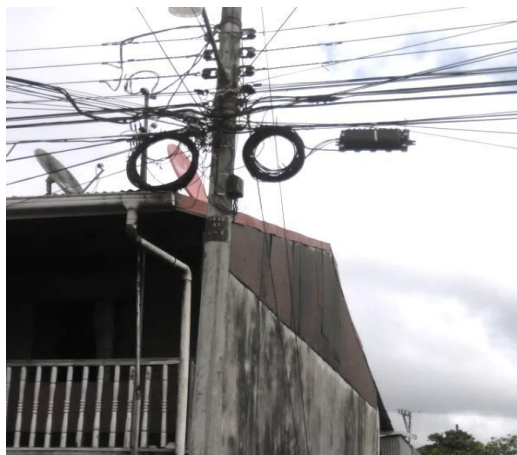
Figura 72: Ubicación de cierre de empalme de fibra en Upala
