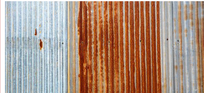
IMG#227 Lamina de zinc
