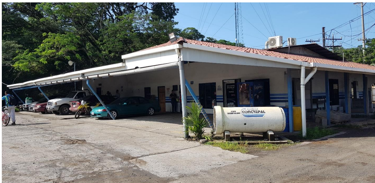
Imagen 10 - Área de oficinas
