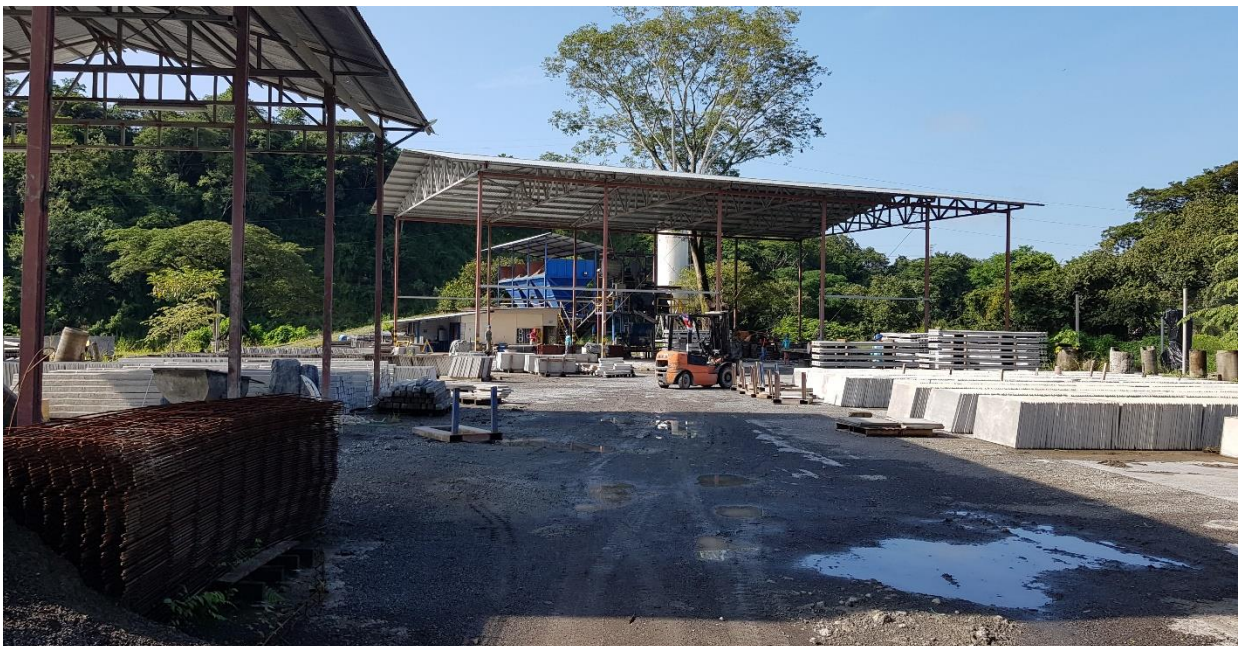
Imagen 6- Área de prefabricado, proceso de producción, área de almacenamiento y despacho
