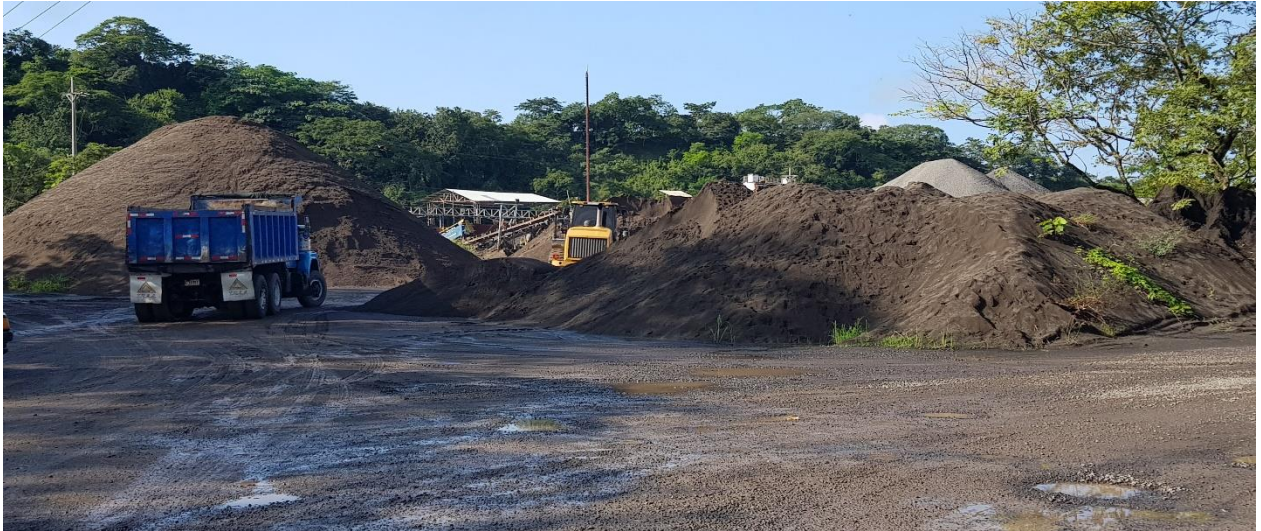
Imagen 2 - Área de agregados
