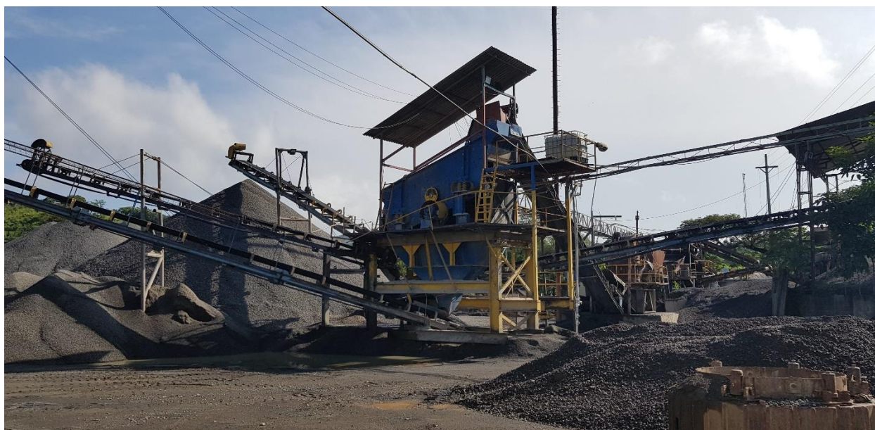
Imagen 9 - Área del quebrador proceso de producción de agregados
