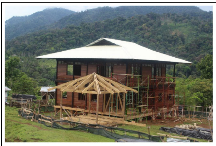
Figura XII. Fotografía tomada del Portafolio de Proyectos de Inversión de Infraestructura y Tecnologías 2019-2023. CCSS
