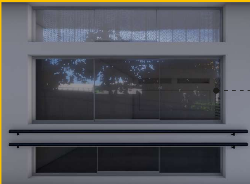
VENTANAS CORREIDIZAS DOBLE VIDRIADO HERMÉTICO PARA REDUCIR LA TEMPERATURA
