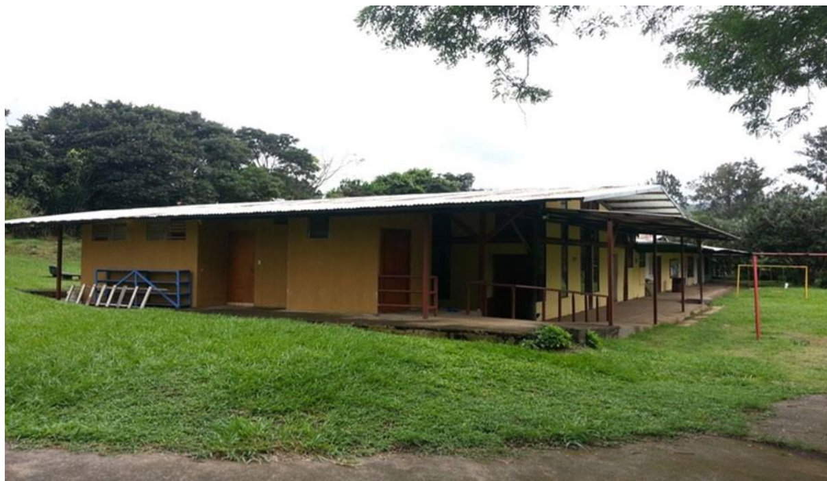
Figura 10: Antiguas instalaciones costado oeste, 2012
