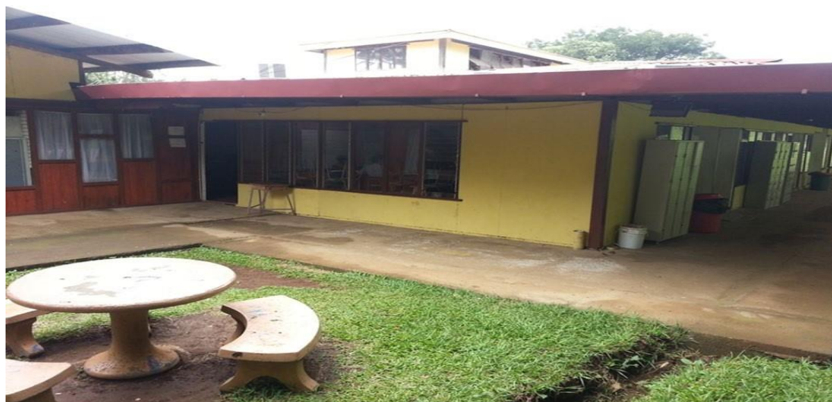
Figura 9: Antiguas instalaciones costado norte, 2012 Fuente: Memoria institucional período 2011-2016 del Colegio Técnico Profesional San Pedro de Barva, página 29.
