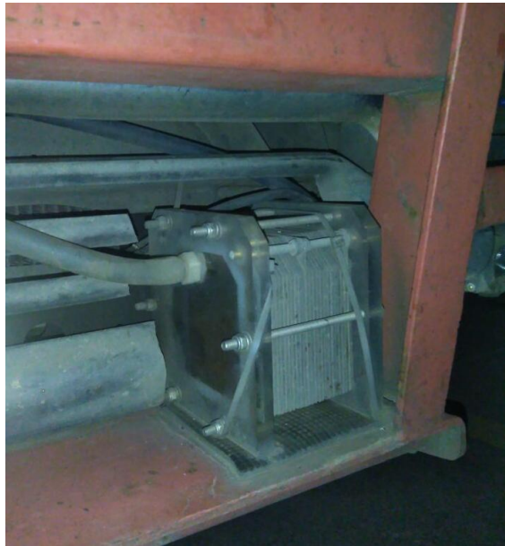
Figura 28 Imagen del montaje de la celda en la cámara del motor
