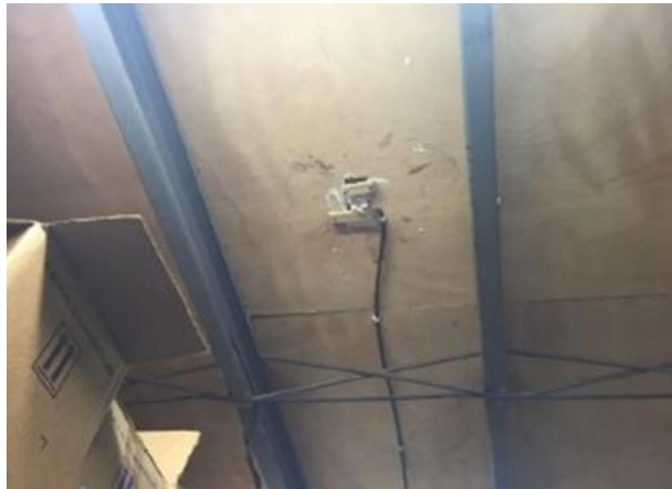
Figura 21 Techo bodega de importaciones Ferva del Norte S.A.
