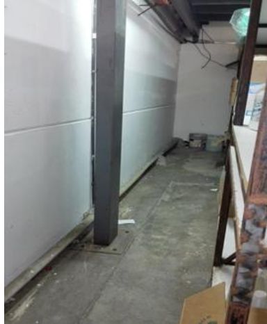
Figura 10 Viga de la Bodega de Importaciones Ferva del Norte S.A.
