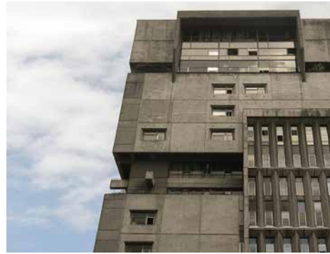
Edificio Jenaro Valverde, CCSS, San José Arq. Alberto Linner Díaz
