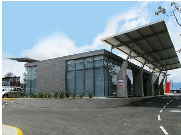
Figura 2. Instalaciones físicas de la oficina de Cacique
