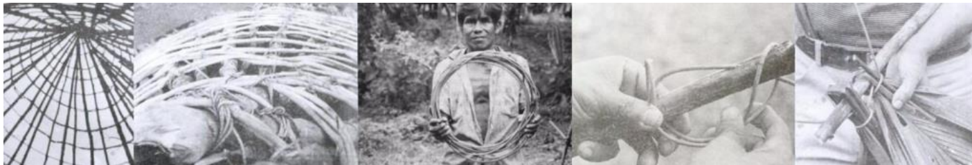
Imagen 175: Proceso constructivo Casa Cónica
