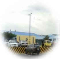
Imagen_33 Vista parqueo CAIS Fuente_ CAIS
