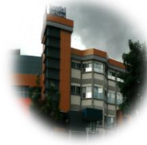
Imagen_36 Vista Frontal Hospital de Trauma Fuente_ Propia
