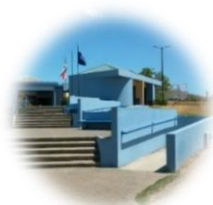
Imagen_10 Acceso principal del CAIS Fuente_Propia
