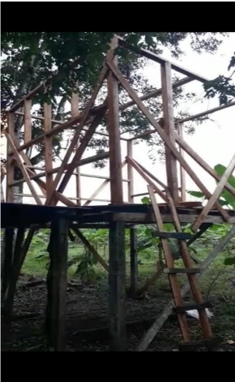
Ilustración 22 construcción de seguridad
