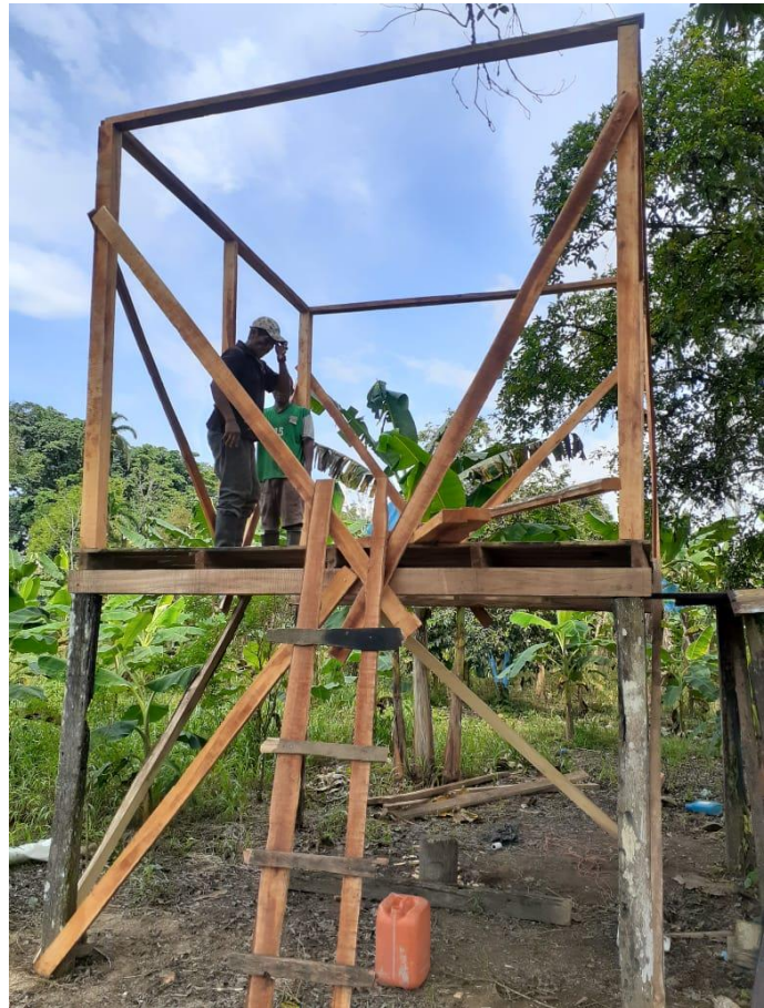
Ilustración 21 construcción de seguridad
