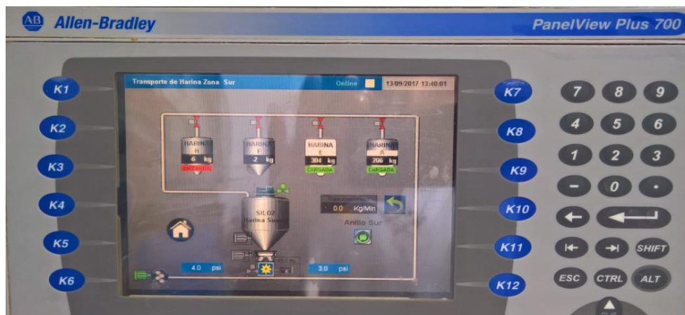
Figura No.19, Pantalla digital de las tolvas dosificadoras de harina y azúcar
