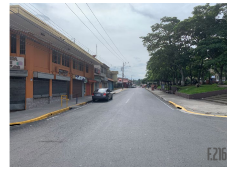
V5. Vista Avenida 30
