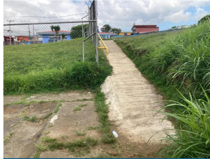
Img#84 Rampa de acceso
