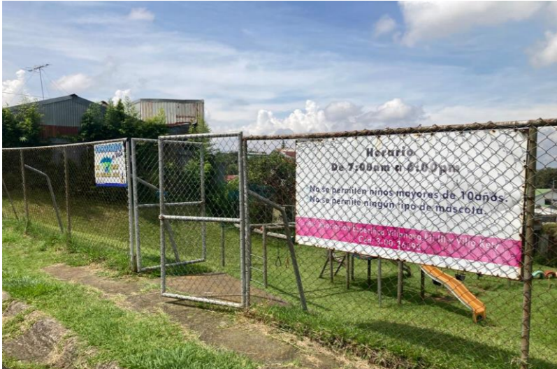
Img#108 Entrada – Etapa 1
