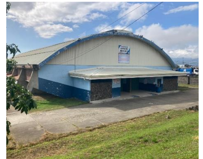
Img#172 Gimnasio Municipal
