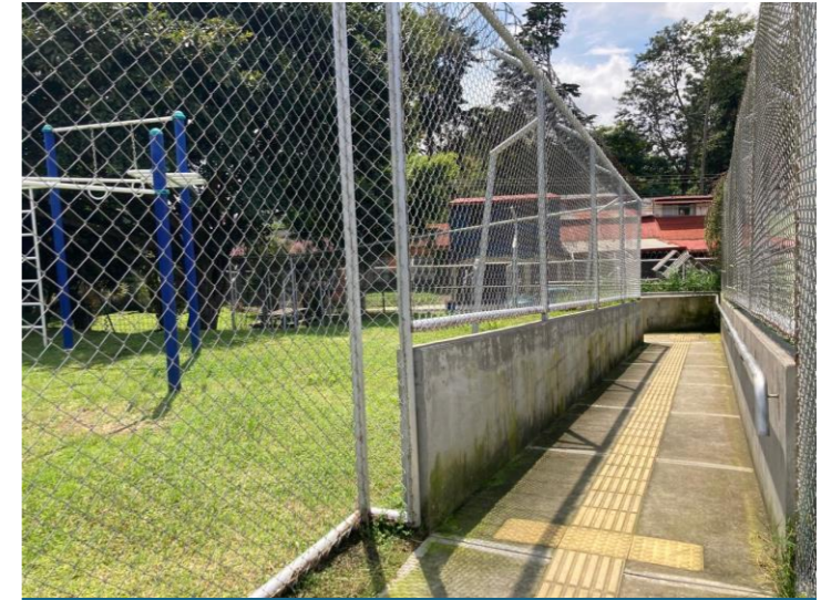
Img#96 Rampa de conexión de etapas
