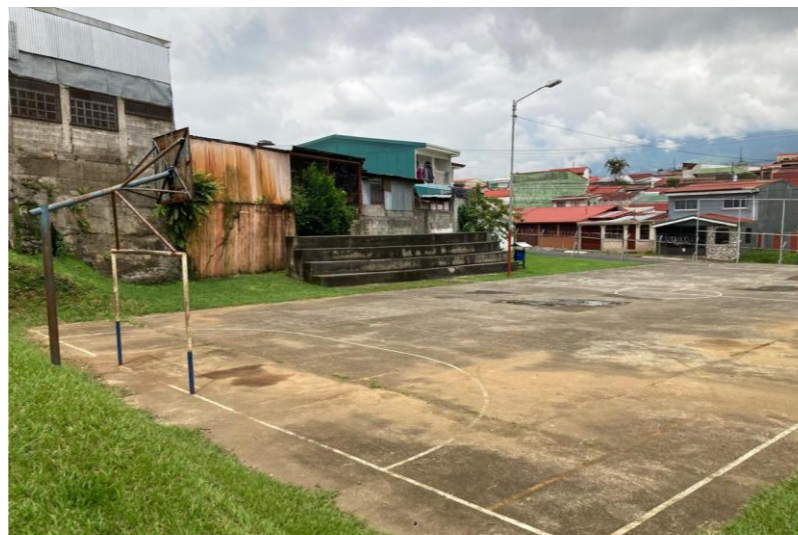
Img#60 Cancha multiuso
