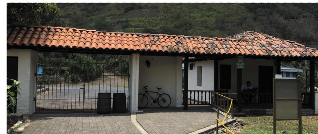
Imagen 183. Caseta de ingreso
