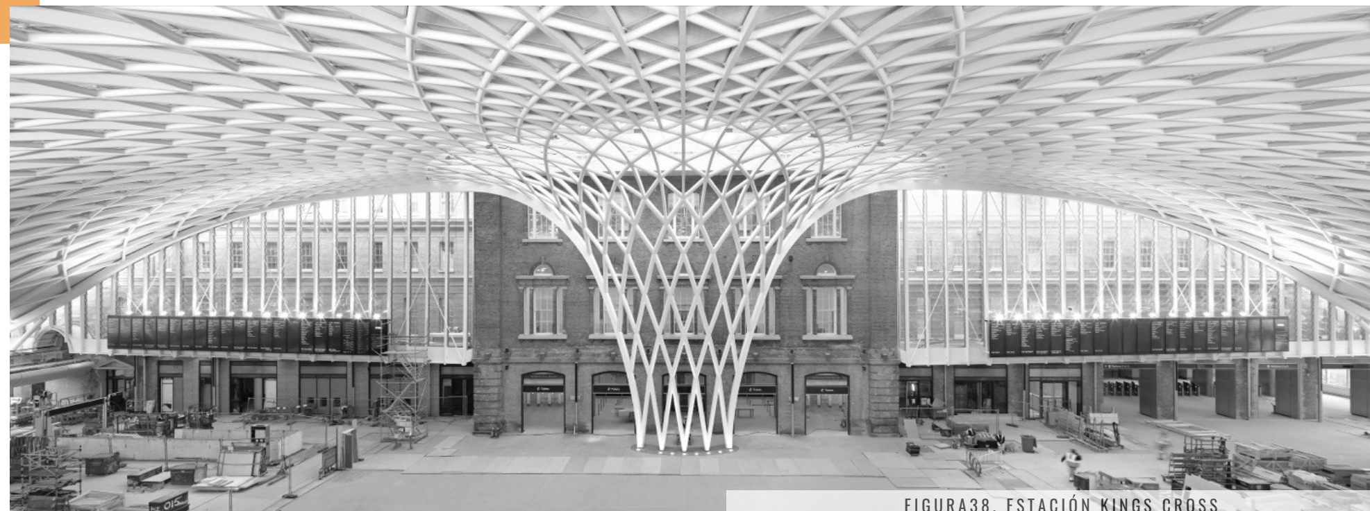
FIGURA38. ESTACIÓN KINGS CROSS
