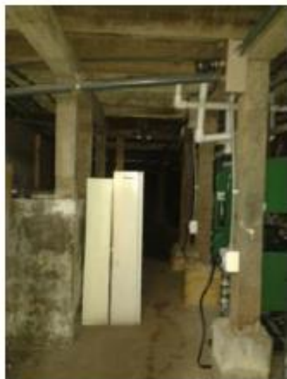
Fig. 1 Lado norte de la cimentación
