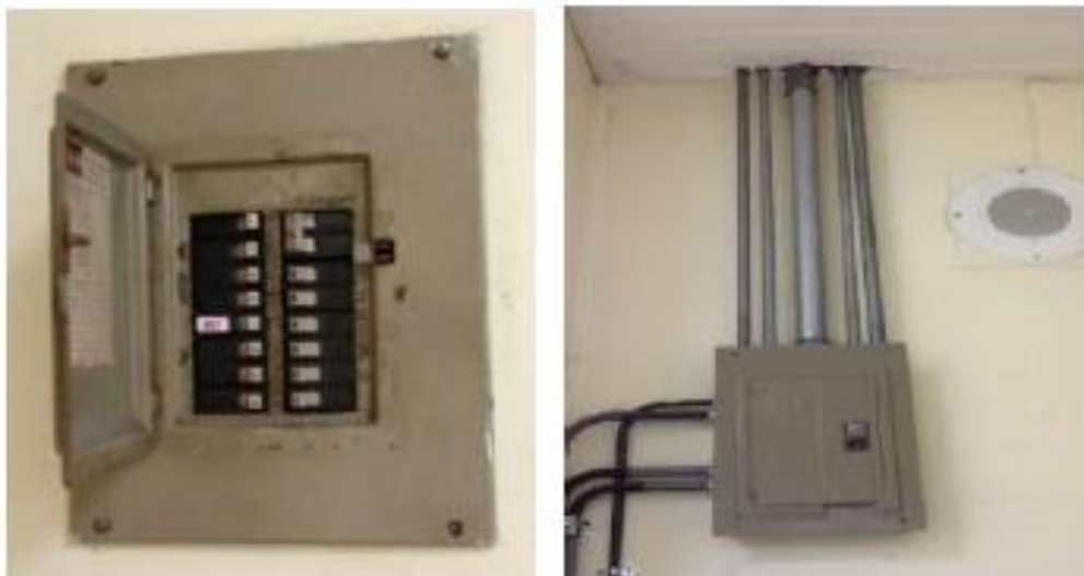
Fig. #8 Muestra de Tableros Instalados
