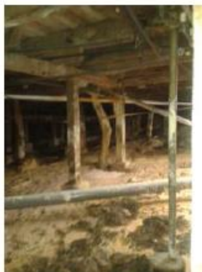
Fig. 2 Lado sur de la cimentación
