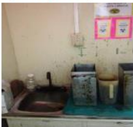
Fig. #7 Tomacorriente inadecuado
