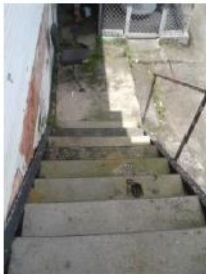
Fig.4 Gradas en estructura metálica y concreto
