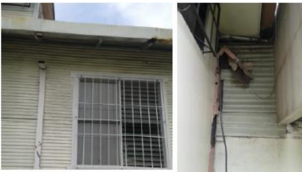
Fig. 6 Sistema de desfogue pluvial
