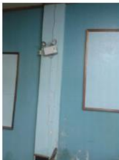
Fig. 9 Columna de concreto del auditorio
