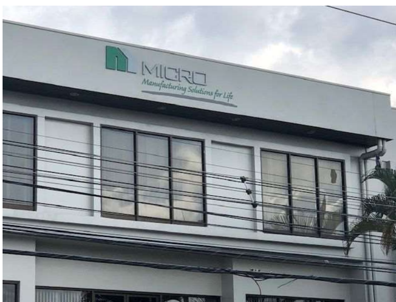
Figura 3 Edificio de MICRO Costa Rica
